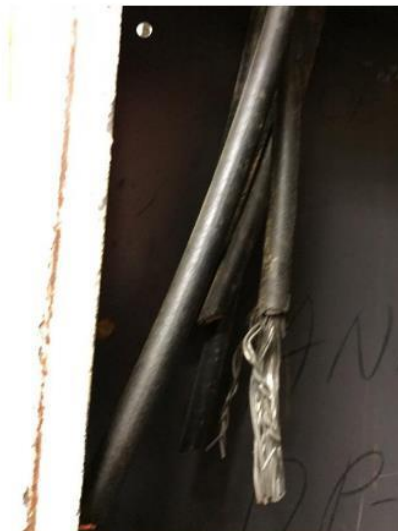
Photo 16: Abandon conduit and wire.
